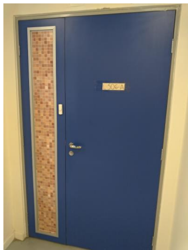
Laboratório L506-A com cobertura no visor da porta de acesso bloqueando totalmente o campo de visão.
