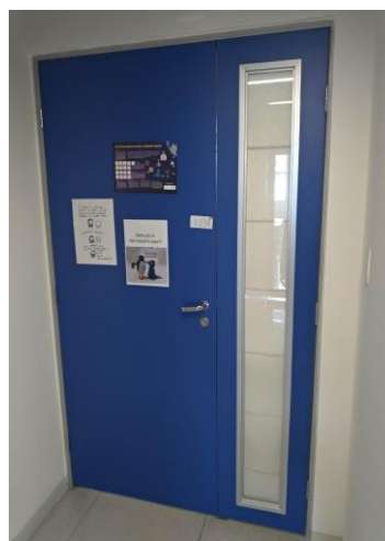
Laboratório L2014 com cobertura no visor da porta de acesso bloqueando totalmente o campo de visão.
